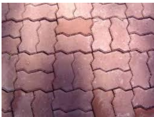
Figura 4 – Detalhe do piso intertravado de 16 faces cor vermelha.
