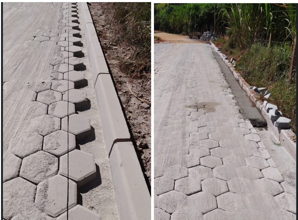
Figura 3 – Alinhamento da largura da sarjeta, corte dos bloquetes e concretagem.
