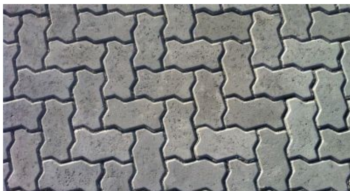
Figura 2 – Bloco de concreto 16 faces com espessura de 8cm e resistência mínima de 35MPa.
