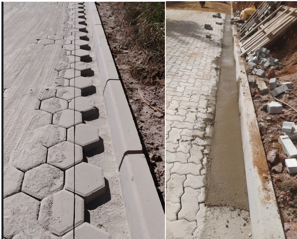
Figura 2 – Alinhamento da largura da sarjeta, corte dos bloquetes e concretagem.
