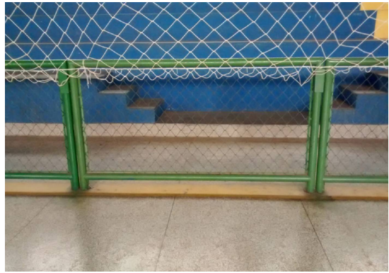
DETALHES DE UNIÃO DOS MÓDULOS DO ALAMBRADO MÓVEL SEM ESCALA
