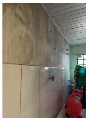
Fotos 07 e 08: Parede do banheiro do Maternal com umidade decorrente do telhado
