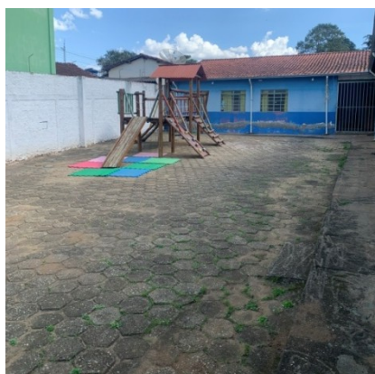
Foto 11: Pátio a ser concretado
