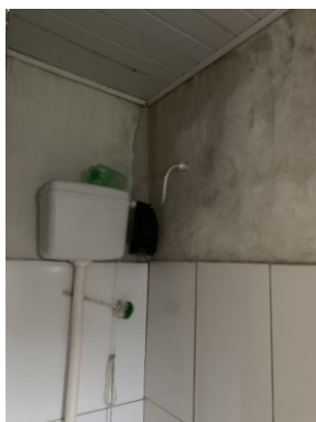
Fotos 07 e 08: Parede do banheiro do Maternal com umidade decorrente do telhado
