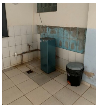
Foto 05: Parede do bebedouro
